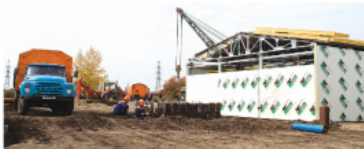
Котельная в Степном построена в рекордные сроки.
